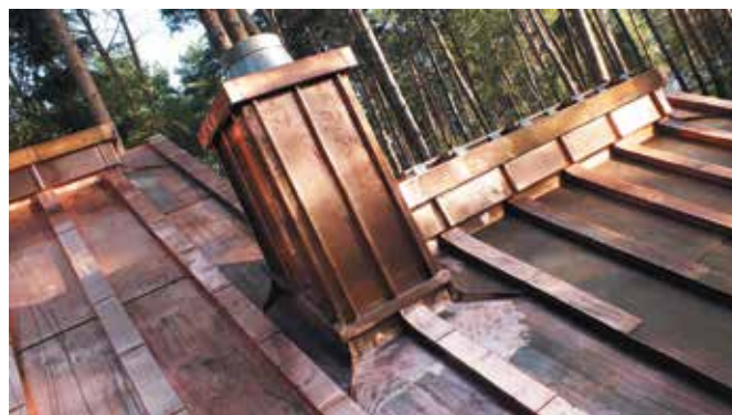
Дымоходная труба: нижняя часть – техника двойного фальца с диагональными полукруглыми конвертами 70 мм (категория В); вертикальная часть – декоративные картины в технике углового фальца 25 мм; верхняя часть – оголовок с двумя уровнями исполнения (верхнее медное обрамление и внутренняя нержавеющая сталь с усеченным конусом); пайка – низкотемпературная с применением газового паяльника Perkeo и припоем (Sn97Cu 3 ).
