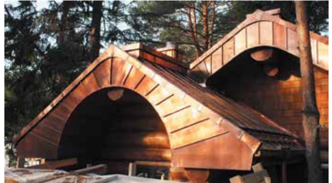
Двухконтурный вертикальный уровень фронтонных свесов с радиусным и эллипсным выполнением: нижний уровень – веерная укладка фальцевых картин с шагом 318 мм (R=1610); верхний уровень – вертикальные картины с шагом 370 мм. Техника исполнения – фасадный угловой фальц 25 мм с полукруглыми удлиненными мысиками и элементами на внешней рейке.
