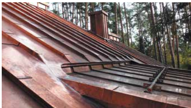
Узел сопряжения кровли реечного фальца 50 мм с навесом, покрытие кровли которого выполнено в технике двойного фальца 25 мм, переходящего в смещенную линию контура декоративных элементов фронтона свеса (внешняя рейка) с применением низкотемпературной пайки.
