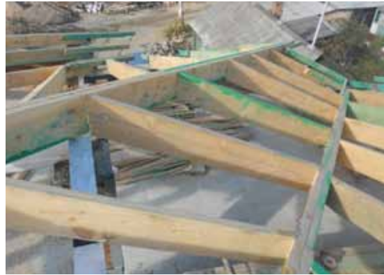
13. Накосная сдвоенная нога в области хребта с примыканием конька и ендовы.
