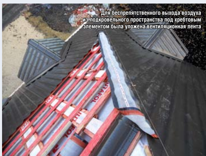
Вид хребта с полукруглой заглушкой в зоне карниза
