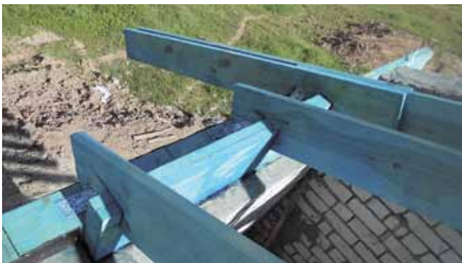
Рис. 7. Фронтальный прогон из двух досок сечением 250x40 мм
