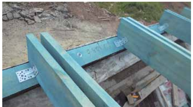
Рис. 11. Узел опирания составных стропильных ног на мауэрлат
