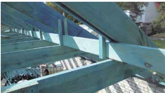
Рис. 8. Консольный прогон из двух досок сечением 150x25 мм
