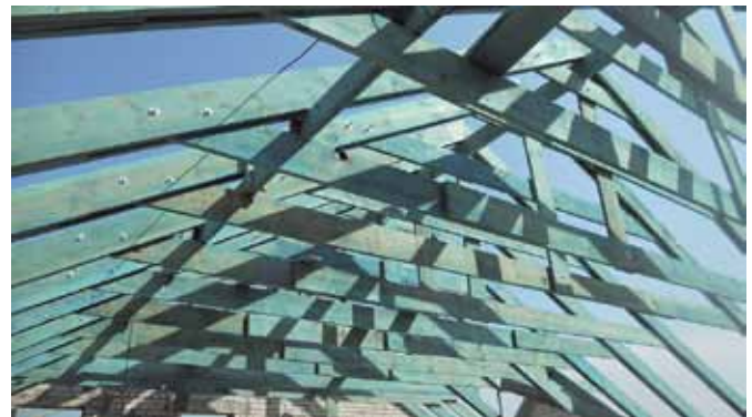
Рис. 10. Общий вид накосных одинарных ног и конькового прогона из досок сечением 250x40 мм
