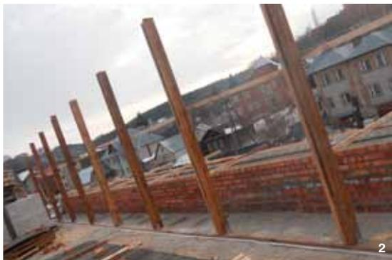
3. Общий вид установленных вертикальных стоек и фронтального прогона сшитого из двух досок 150×40 мм
