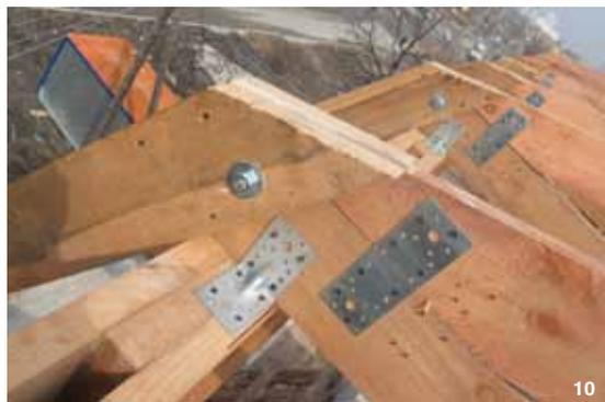
11. Узел крепления двойной затяжки под коньковым прогоном (второй скат кровли 18°)
