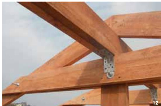
13. Примыкание стропильной ноги к фронтому здания с изоляцией конькового прогона
