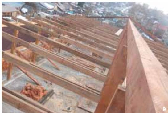
8. Узел соединения ригеля с составной стропильной ногой первого ската (в процессе монтажа)
