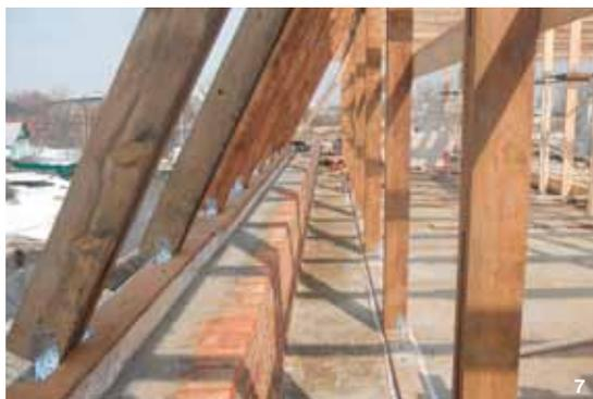
6. Узел крепления стропильных ног (первый скат кровли 63°) при помощи усиленных уголков 90×90 мм толщиной 2 мм
