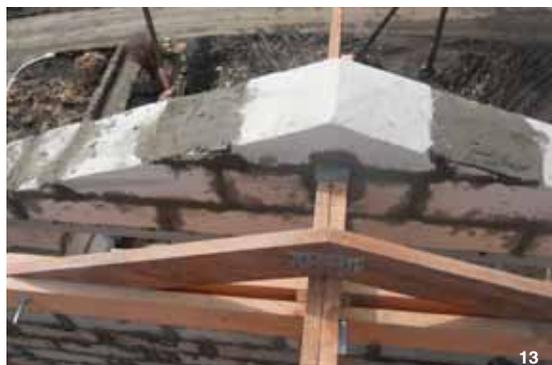
приступили к установке ригелей в комбинированном варианте соединения. В составном сдвоенном варианте центральная часть ригеля выполняется из двух досок с зазором между ними 40 мм. Впоследствии в этом зазоре будут закреплены стойки конькового прогона (рис 4) и подкосы в зоне холодного чердака.
