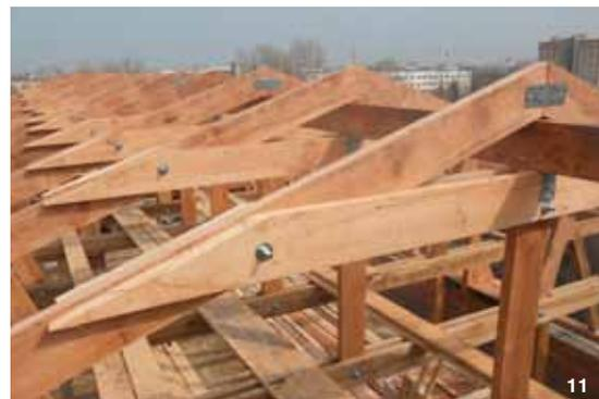
12. Узел крепления конькового прогона, затяжки и стойки
