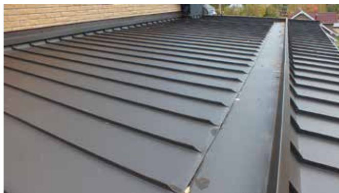
Общий боковой вид укладки прямых фальцевых картин шириной 300 мм на верхнем навесе со стороны водоотводящего лотка
