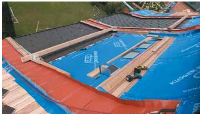
Технологический хронометраж укладки гонтов на вогнутой поверхности кровли предполагал использование канатной системы ходовых мостиков из квадратного бруса сечением 150x150 мм
