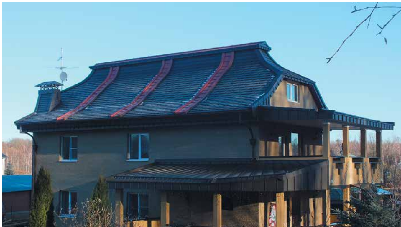
Декабрь 2015 года стал завершающим этапом кровельных работ; общий вид со стороны внутренней части подворья
