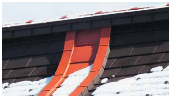
Зимние виды различных декоративных поверхностей – реечный и Г-образный стоячий фальц, плоский гонт на внутренней и внешней рейках, а также плоский усовершенствованный гонт взацеп
