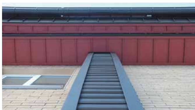
Сопряжение вентиляционной шахты и подкарнизного свеса кровли выполнено в разных цветовых оттенках матового типа
