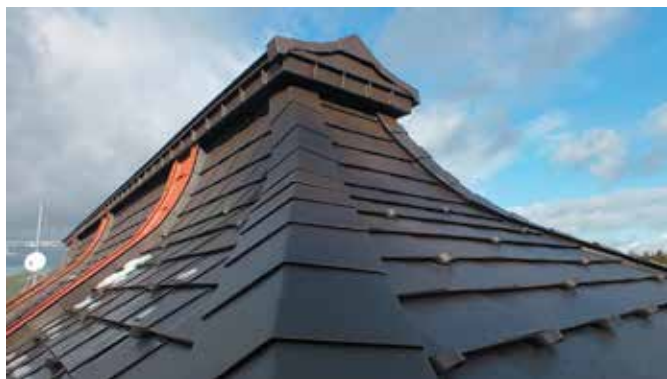
Экстерьер коньковой части кровли напоминает симбиоз двух похожих между собой архитектурных стилей – бурятского и японской пагоды
