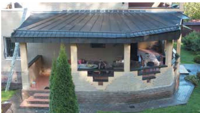
Общий вид хода монтажа кровельных работ по укладке фальцевых картин на нижнем навесе (верная укладка)
