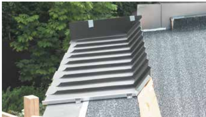
Процесс укладки малых фальцевых картин с подрезкой полукруглых мысков и примыканием к лежащему водостоку
