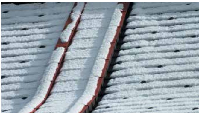
Общий вид парящей воздушности реечного фальца с разделением на зоны основного кровельного покрытия проявляется даже после выпадения легкой прослойки снежной массы
