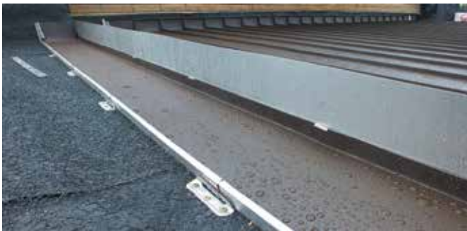
в) разметка промежуточной угловой картины под малые фальцы 24+9 мм (вид со стороны) высотой с обрезаемой стороны 150 мм
