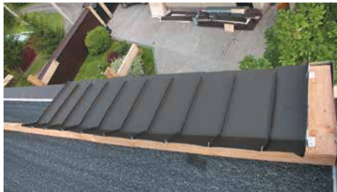
Общий вид установленных малых фальцевых декоративных картин перед лежащим водостоком (треугольный брус 150 мм) и сформиро- ванным фронтовым элементом
