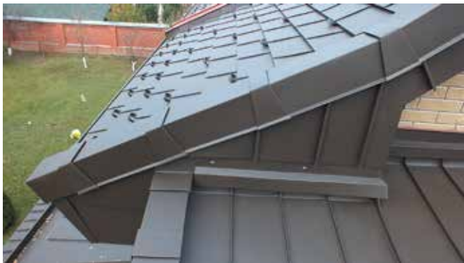
Декоративное выполнение фронтового угла сопряженного с при- мыкающим навесом кровли
