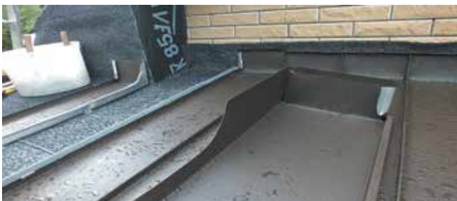
г) подготовленная к монтажу угловая картина с обязательным применением ленты ПСУЛ шириной 9 мм на соседних рядовых картинках (пологий уклон навеса)
