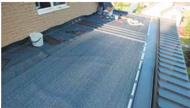
Общий вид верхнего пологого навеса с укладкой объемной диффузионной мембраны KLOBER Sec Metal и началом монтажа фальцевых картин
