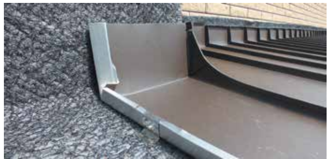
ж) вид рядовой картины со стороны имеющей прямой и полукруглый конверты (двойной фальц) с примыканием высотой 150+25 мм к вертикальной части короба фронтона кровли
