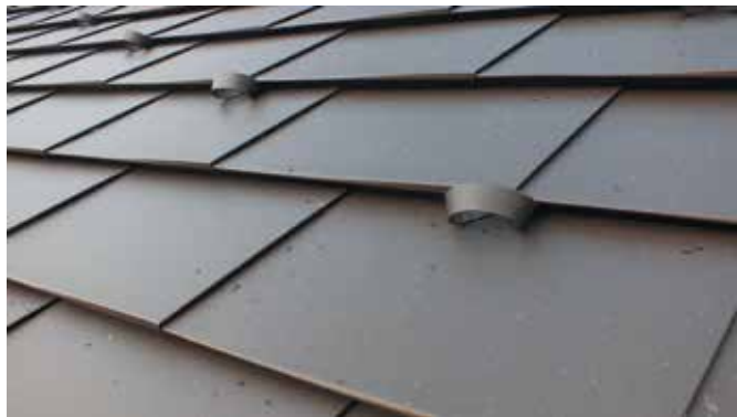
Плоский усовершенствованный гонт с установленными в определенном порядке точечными снегоstopорами ручной работы
