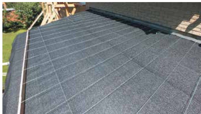
Проверочная разметка кровли навеса перед началом укладки картин и сверка по их количеству с технической картой из проектной документации
