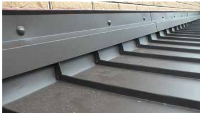
Общий вид примыкания картин пологого навеса к вертикальной стене с нанесенным полиуретановым герметиком и установкой декоративных колпачков
