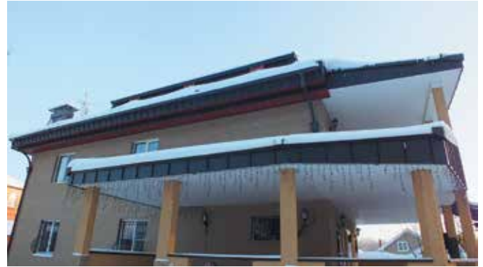
Венчающие карнизные части кровли и навесов декорированы малыми и большими фальцевыми картинами
