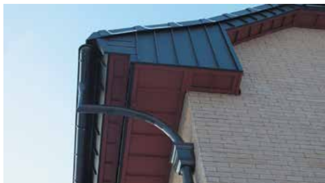
Сегментарное выполнение водосточного колена обусловлено большой глубиной карниза и выполнено в швейцарском стиле
