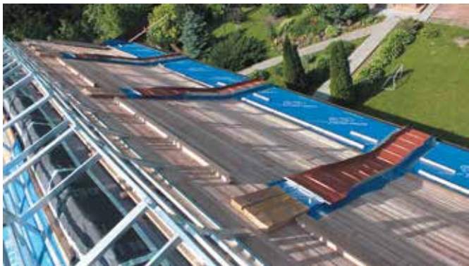
Технологический процесс монтажа фальцевых картин реечного фальца на скатной кровле в старинной утраченной технике исполнения
