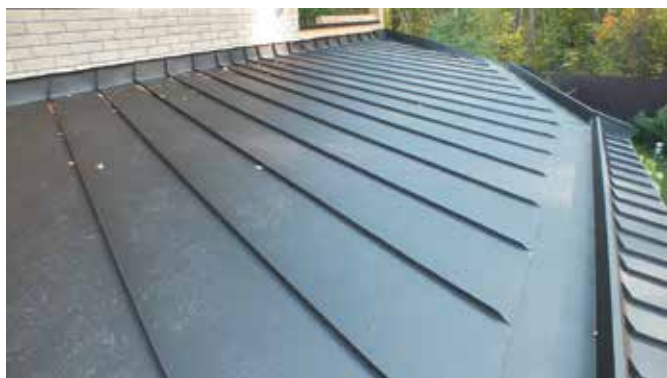
Общий вид верхней укладки конусных фальцевых картин шириной 250/520 мм на нижнем навесе кровли со стороны фронтона
