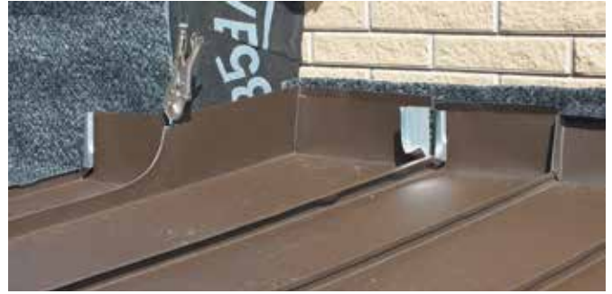
д) общий вид угловой картины соединенной между рядовыми картинками в одинарный фальц (первый проход)
