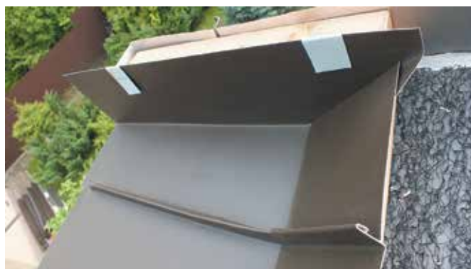
Угловая картина лежащего водостока выполнена в технике двойного стоячего фальца (лотковый и прямой конверты)
