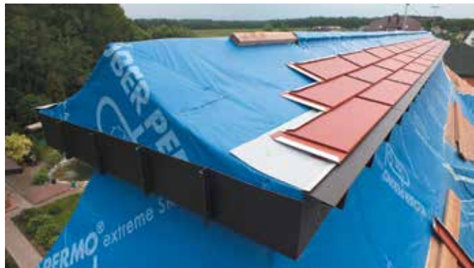
Процесс проведения монтажных видов работ по укладке декоративной алюминиевой черепицы ручной работы
