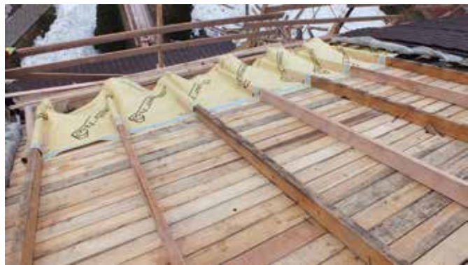
Начало санации кровли пленкой Wallint T3
