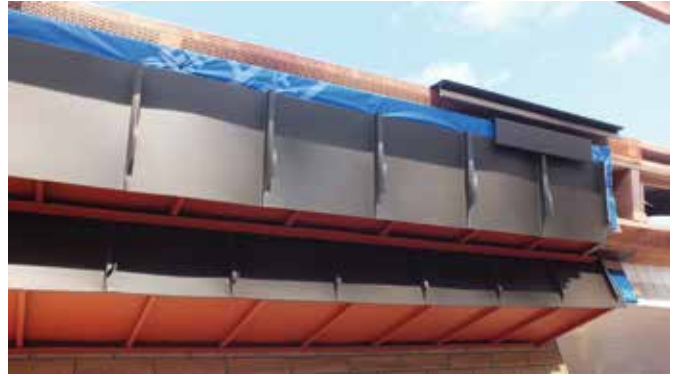
Сборка элементов в зоне притока воздуха для вентиляции подкровельного пространства
