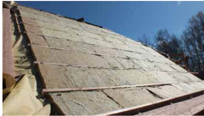
Общая толщина укладки теплоизоляции составила 200 мм
