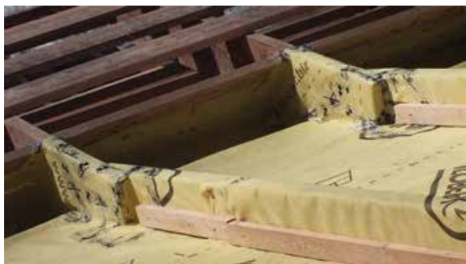
Узел сопряжения пароизоляции и стопорной доски теплоизоляции
