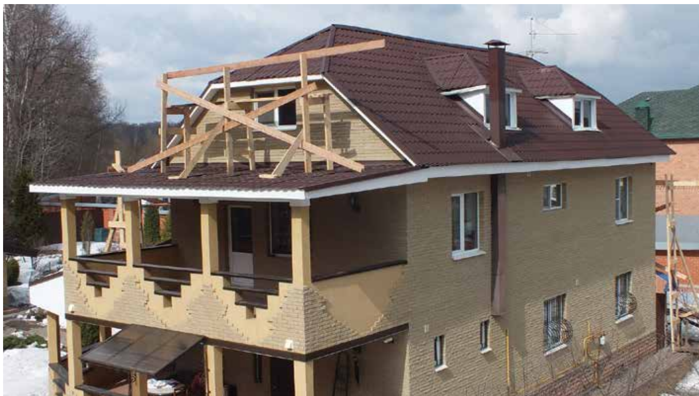
Общий вид кровли до начала реконструкции
