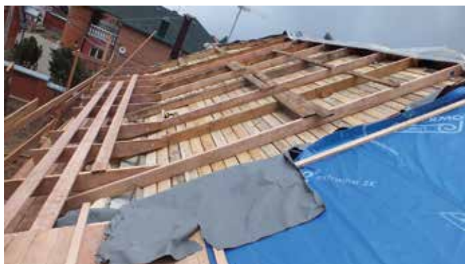
Монтаж кобылок на карнизном свесе кровли
