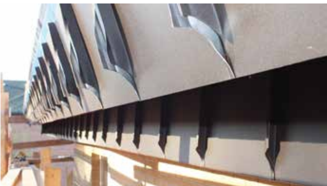
Укладку верхних ветровых элементов производили с подрезкой полукруглых мысиков
