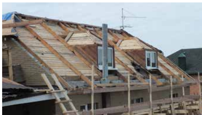
Общий вид кровли перед началом работ по реконструкции
