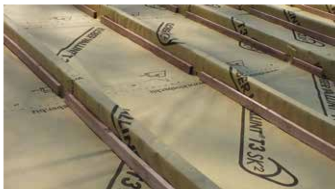
Завершение работ по санации кровли жилой мансарды
