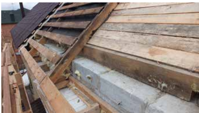
Локальный участок кровельной конструкции после вскрытия
