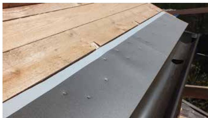
Монтаж стальной фальш- и алюминиевой карнизной планки
