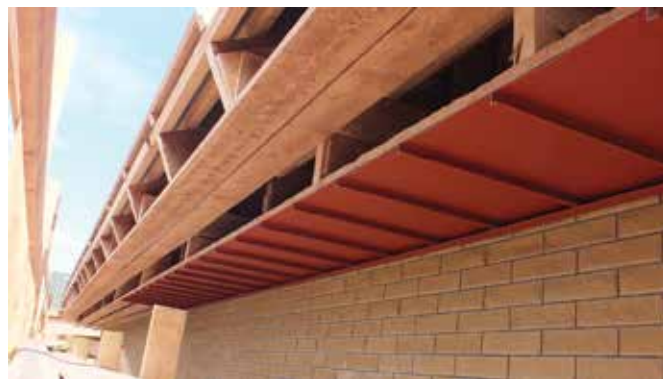
Начало укладки декоративных фальцевых картин на нижнем уровне
