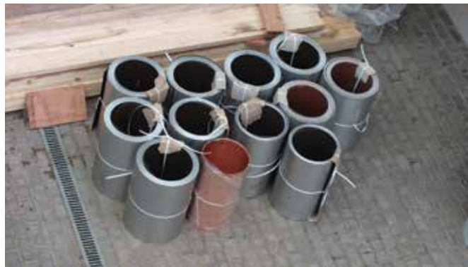
Алюминий был привезен на объект в виде штрипса в малых роликах
