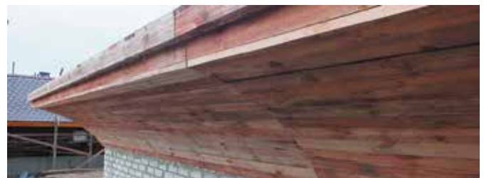
Карнизные радиусные зоны кровли после завершения плотницких работ
