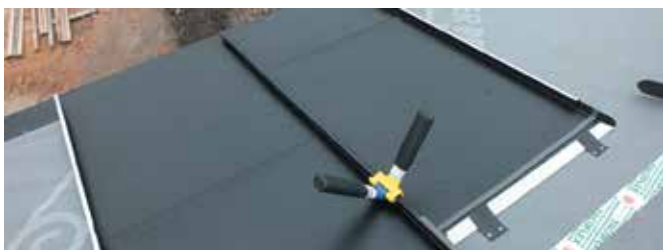
Обжим Г-образных декоративных замков высотой 25 мм на фальцевых картинах частично производился малой рамкой FREUND
