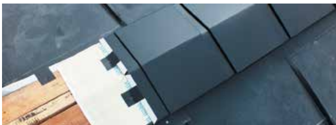
Малые декоративные коньковые элементы на внутренней рейке и скрытых кляммерах
