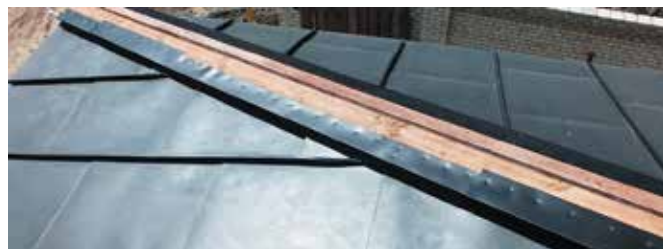
Монтаж выравнивающих скрытых фальш-планок хребтового элемента перед финишной установкой декоративных элементов
