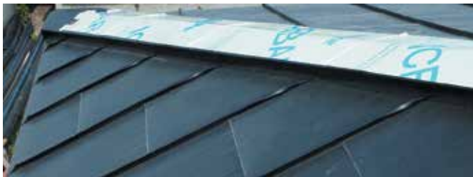
Общий вид примыкания фальцевых картин к хребту вальмы защищенного битумной изоляцией Tegola Icebar
