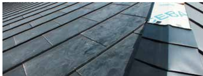
Укладка изготовленных вручную декоративных облицовочных элементов на хребтах кровли с применением дополнительной изоляции в виде специального тонкого самоклеющегося битумного ковра Tegola Icebar
