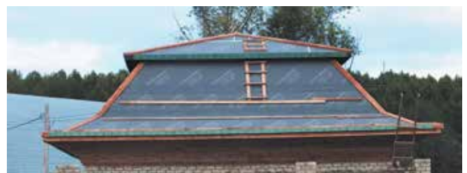
Общий вид кровли с юго-восточного фасада здания
