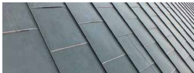
Общий вид после укладки фальцевых картин в шахматном порядке (сетчатый узор)
