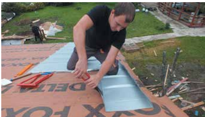
Отбортовка боковых частей картины конвертными клещами
