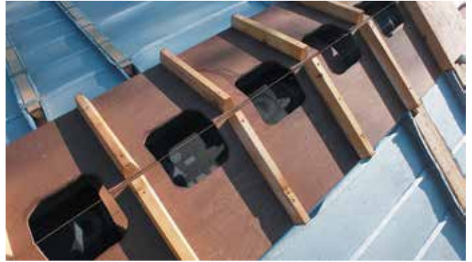
Подконструкция вентилируемого конька выполненного из деревянных брусков и фанеры ФСФ
