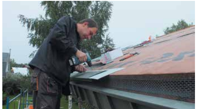
Установка на карнизном свесе кровли фальш- и карнизной планок
