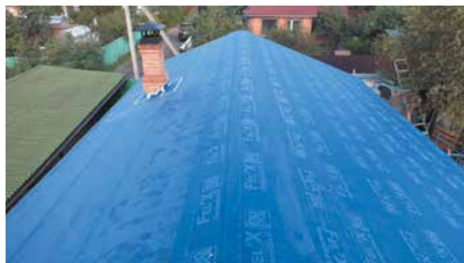
Укладка битумного подкладочного ковра ICOPAL по сплошному основанию выполненного из обрезных досок толщиной 25 мм
