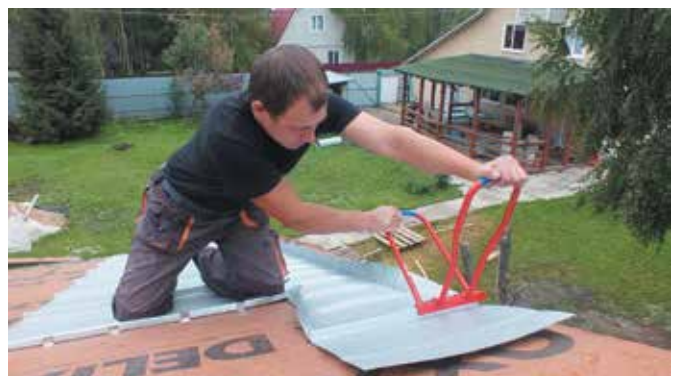
Обжим фальцевых картин специальным инструментом – универсальной рамкой STUBAI
