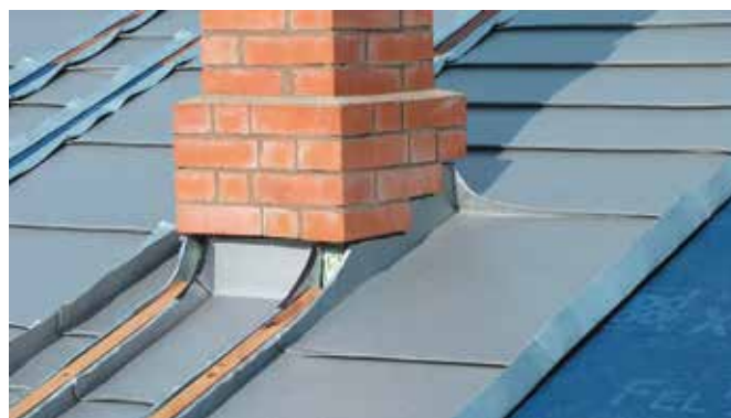
Обход дымоходной трубы в технике реечного фальца
