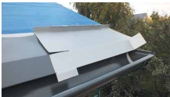
Установка первой фальцевой картины на карнизном свесе (шведский вариант)
