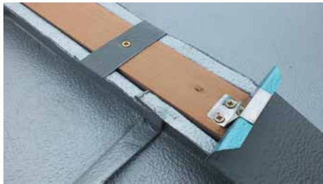
Узел крепления декоративных рядовых реечных элементов
