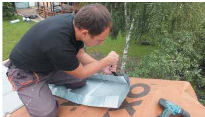
Свертывание угла (конверт) картины в коньковой части кровли специальным инструментом – цаплей
