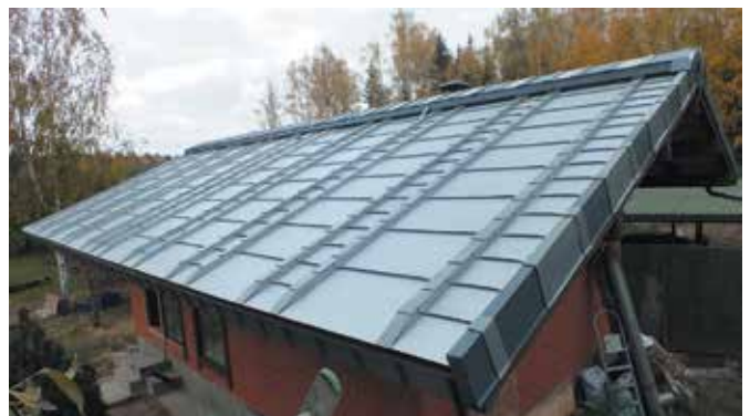
Общий вид кровли в старинной утраченной технике реечного фальца ручной работы
