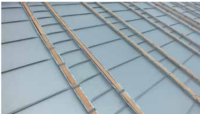
Укладка V-образных деревянных брусков между картинами
