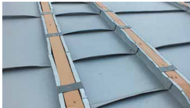
Двухстороннее крепление боковых частей картин кляммерами;
