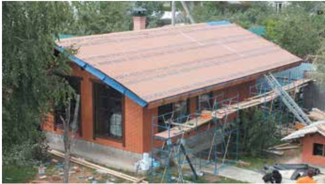
Укладка разделительного слоя в виде диффузионной мембраны
