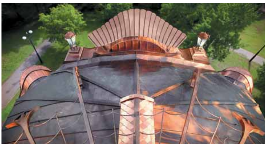
Парящий вид кровли над западным фасадом здания показывает всю трудоемкость выполнения кровельных работ и изящность профессиональной техники исполнения с технологией создания сложных узлов со множеством деталей и единым подходом ко всем элементам.
