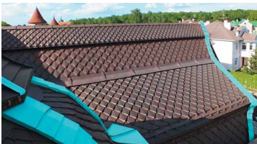
Обзор участка Корабль со стороны Бутона Болотной Лилии. Гибридная технология выполнения работ в технике Tilework & Falzwork. Малоразмерная штучная черепица в виде объемных ромбов и плоских гонтов с бугелями на карнизном свесе, а также в формате реечного фальца. Красная и патинированная медь.
