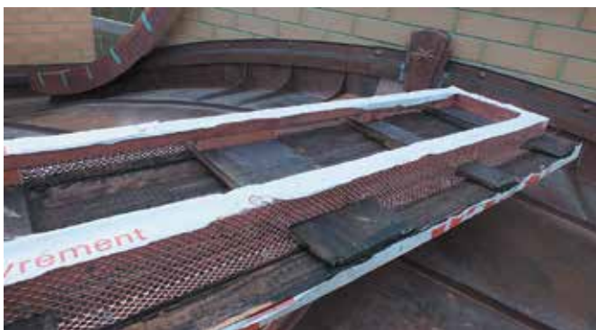
(г) Показательно перевернутая нижняя часть крышки аэратора с сеткой
