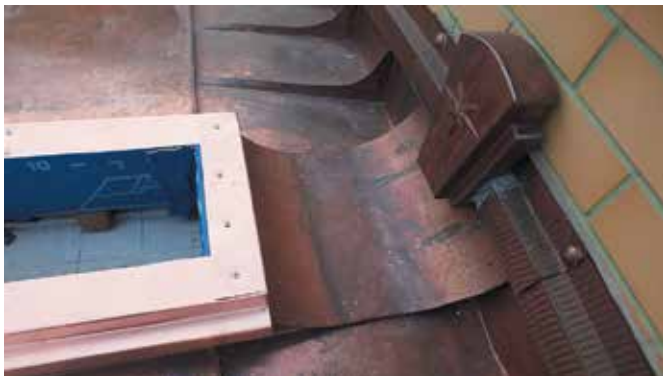
(в) Вид сверху – подконьковые декоративные планки и примыкание к стене
