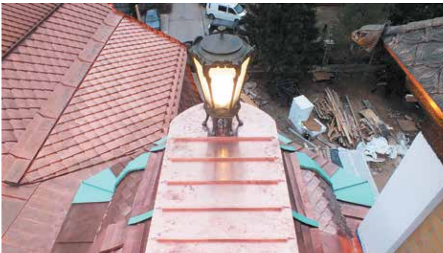
Зимний монтаж 2015 года декоративного функционального фонаря на пологий участок купола – первоначальная идея до момента установки лапы Виверны весной 2016 года
