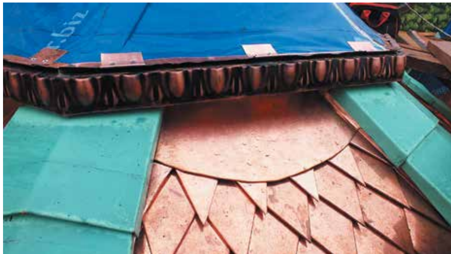
Фигурная объемная чеканка (выколотка) с чернением и лаком как граница из тонкой переходящей нити визуально разделяющая две конструкции – купол и наверхши. Изготовление – художественная студия Елены Ивановой
