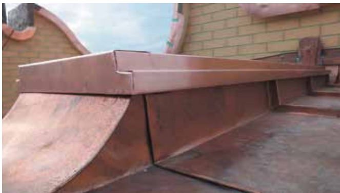
(б) Монтаж декоративных подконьковых планок ступенчатого типа
