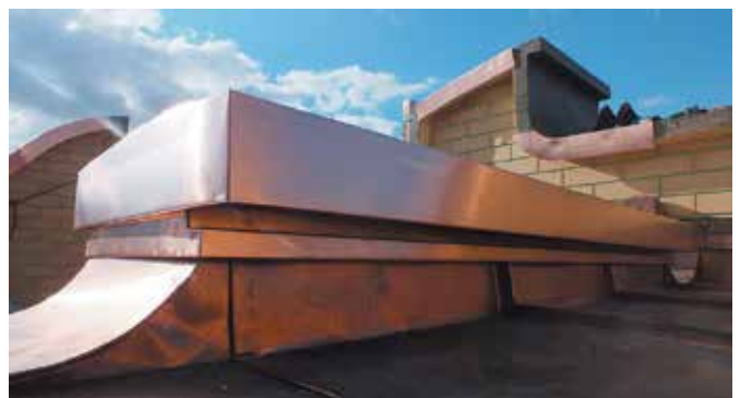
(е) Общий вид установленных планок на фоне фальцевых картин
