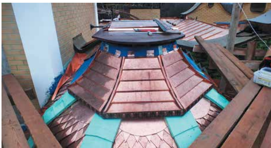
Завершающий этап работы по декорированию наверхши купола гонтами с малой амплитуды подъема по вогнутой поверхности с применением специальной развертки – трапецидальная форма
