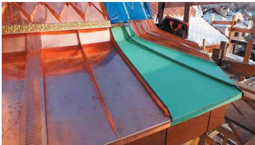
Общий вид установленной лебединной лапки в виде фальцевой картины в технике двойного стоячего фальца с применением полукруглых конвертов и подрезкой полукруглых мысиков на карнизных свесах
