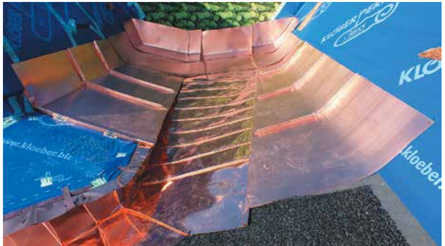
Пологий участок кровли между двумя различными конструкциями (снежный мешок) выполнен картинками в технике двойного стоячего и лежачего фальцев. Слева – картины со стандартными прямыми конвертами (круглогубцы), справа – скругленные безконвертные фальцы (гофрователь)
