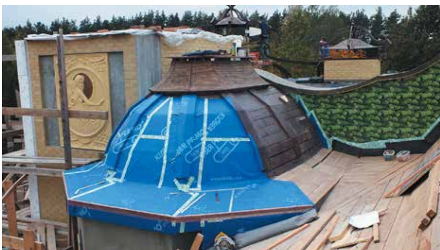
Устройство сплошного основания и укладка синтетической изоляции Klover Extreme по всей поверхности каркаса купола с применением специального армированного скотча D-Tack Tacoflex
